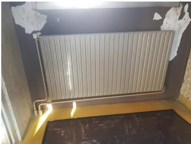
Photo 1 : Radiateur et sa vanne de régulation
